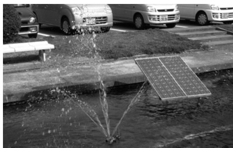
自然エネルギーを利用した噴水装置
