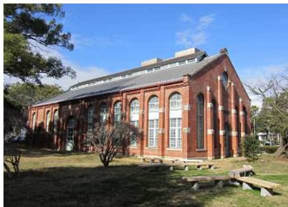
図 1 熊本大学工学部研究資料館の外観
