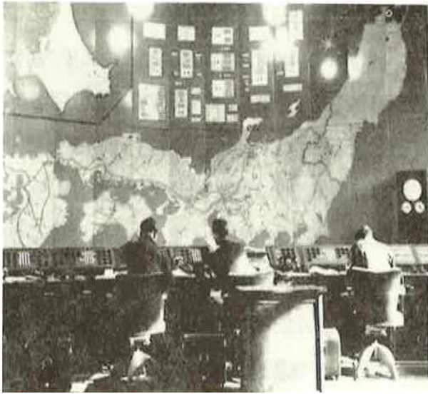
写真 中央給電連絡所（1951 年当時）
