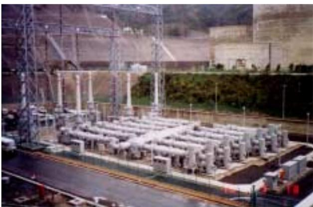
図 1 . 日本原子力(株) 敦賀発電所の 500 kV GIS
