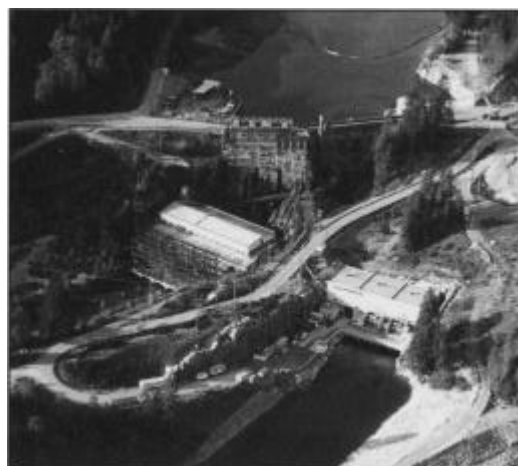
図3 新旧発電施設
