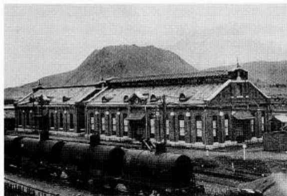
碓氷峠 矢ヶ崎変電所蓄電室
