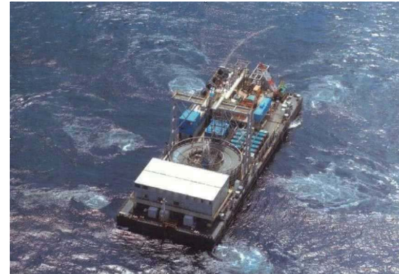
電力ケーブル布設船 (90 × 30m, 喫水 3m) (河野ら '05, '08) [More]
