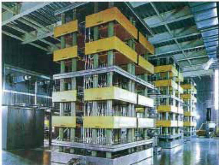
交直変換設備
