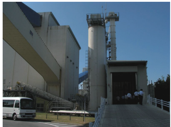
図12 沖縄電力 具志川火力発電所
