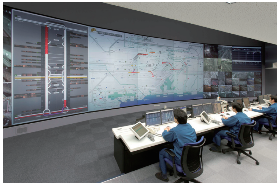
首都高速道路交通管制室（平河町）AISS'09
