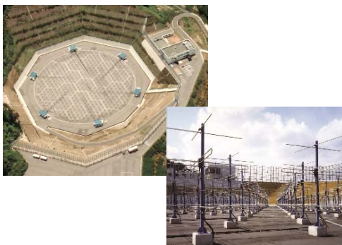
MU レーダー全景 (京都大学生存圏研究所信楽MU観測所) (左) とMU レーダーアンテナ群近景 (直交3素子八木アンテナ) (右)
