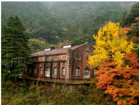
旧端出場水力発電所
