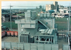
がすぜつらんかいせつち ガス絶縁開閉装置 Gas Insulated Switchgear
