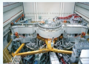
ブレイクベン 臨界プラズマ試験装置 JT-60 Breakeven Plasma Test Facilities JT-60
