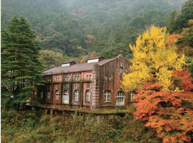
旧端出場水力発電所は、明治維新以降の別子銅山の近代化に対応するため、1912年（明治45年）に住友別子鉱業所により建設されました。当時国内一の約600メートルの落差を利用した出力3000kWの発電所であり、その特徴は、長距離高圧送電方式による電源開発ではなく、電力需要地にある発電所まで、水源の河川から水路と鉱山用トンネルを利用して、その流水を貯水槽に集め、高圧鉄管の落水で発電したところにあります。
